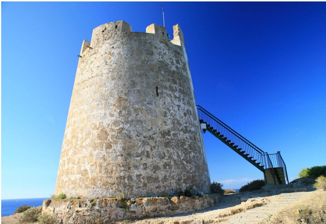
Fig. 14. Lato nord al 2012 (foto A. Cuboni).
