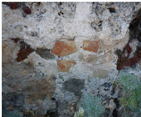
Fig. 7. Particolare della muratura nel lato sud-est.
