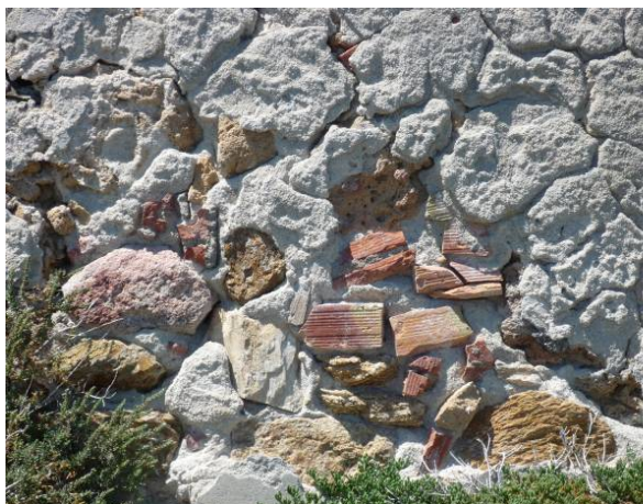
Fig. 6. Particolare della muratura presso il lato sud-est.
