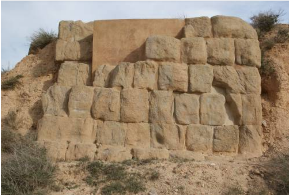
Imagen 6. Torre de la muralla occidental del Pla d'Almatà.
