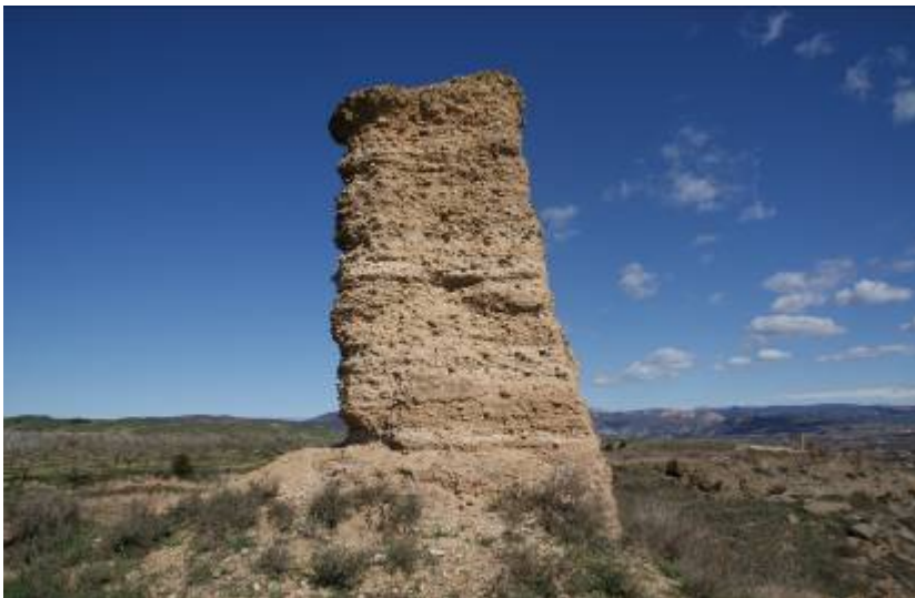
Imagen 5. Detalle del tapial de tierra, cal y árido.
