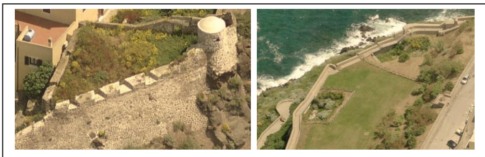
Fig. 21 Terrapieni moderni sul versante sud ovest e nord delle mura (fonte: https://www.sardegnageoportale.it/webgis2/sardegnafotoaeree/ ).
