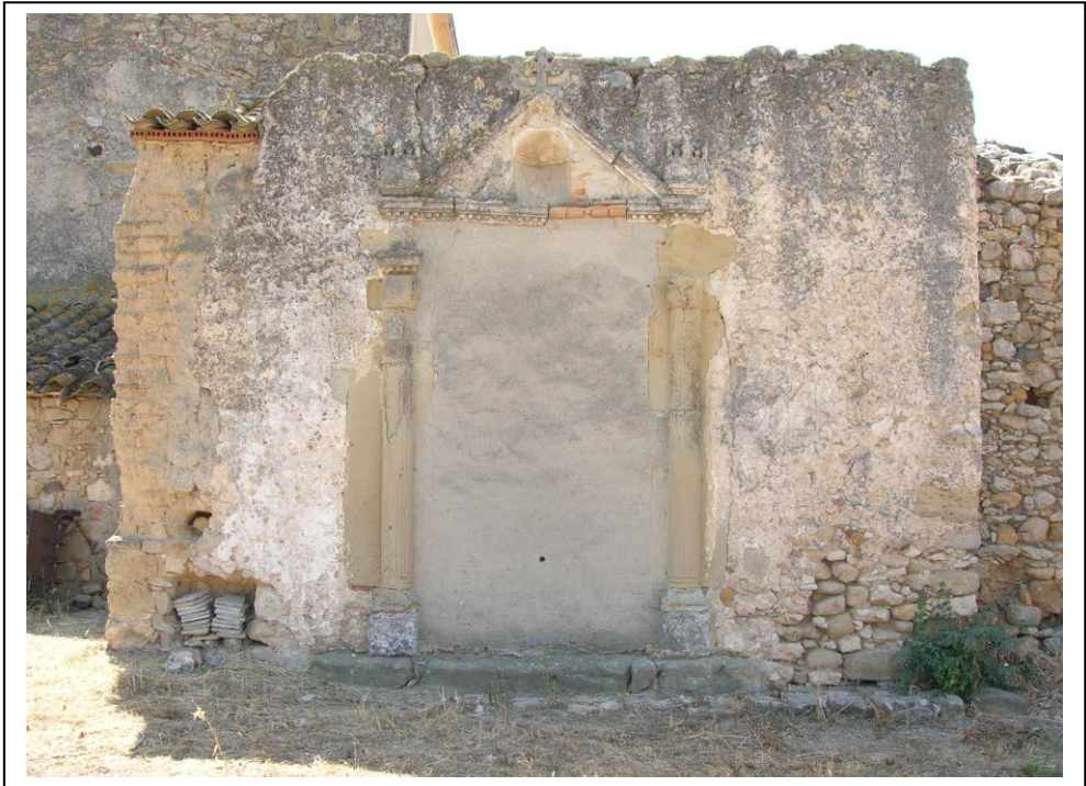
Fig. 6 Ruedri del portale d'accesso alla chiesa di Santa Rosa, antica cappella gentilizia del palazzo baronale di Samatzai.
