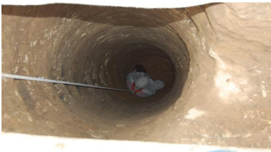
Fig. 4. Il pozzo di via Satta in corso di scavo.
