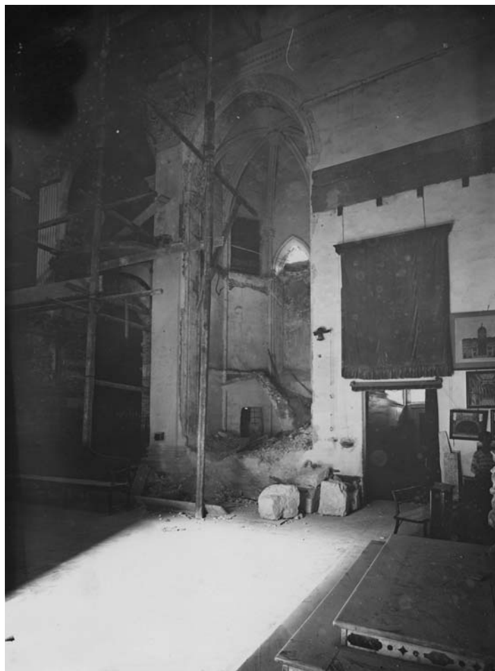
Fig. 9 Cattedrale di Santa Maria di Castello (Cagliari). Cappella del braccio sud del transetto (Foto Archivio SBAPSAECA-OR, n° 2554).
