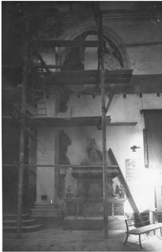
Fig. 11 Cattedrale di Santa Maria di Castello (Cagliari). Restauri della cappella del braccio sud del transetto (Foto Archivio SBAPSAECAOR, n° 2555).
