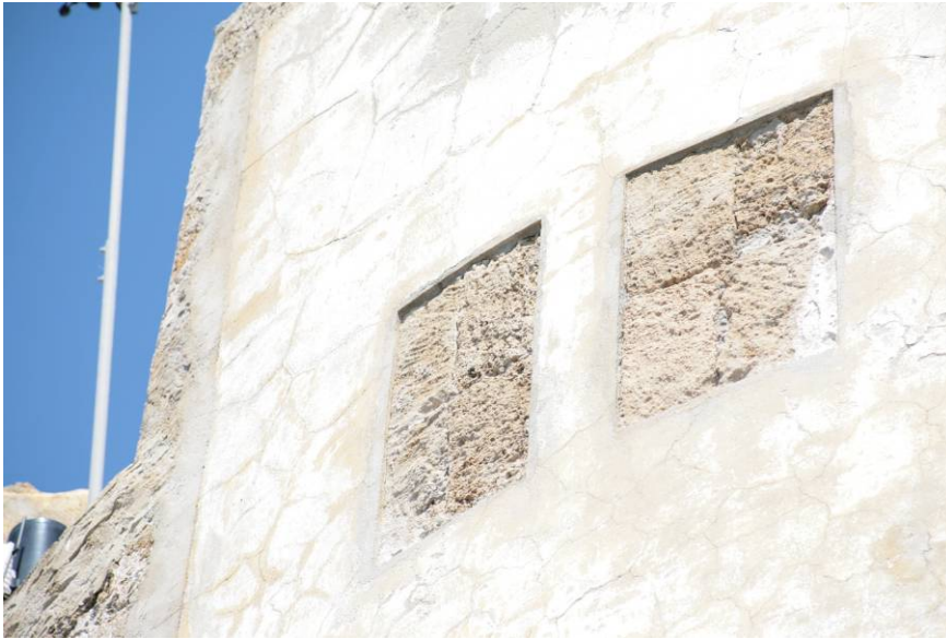
Fig. 4. Riquadri con pietre squadrate risparmiate dall'intonaco moderno.
