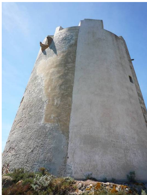
Fig. 11. Lato est al 2012.
