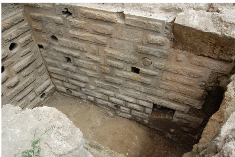
Fig. 22. Muro esterno del barbacane del castello. In basso a destra la porta sulla via di fuga.
