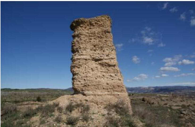
Imagen 5. Detalle del tapial de tierra, cal y árido.
