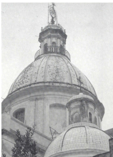
Fig. 10. Córdoba, Chiesa di Santo Domingo (1858-1862). Cupole. Autori del progetto A., G. e N. Canepa. (Da Arquitectura en la Argentina , 1980).
