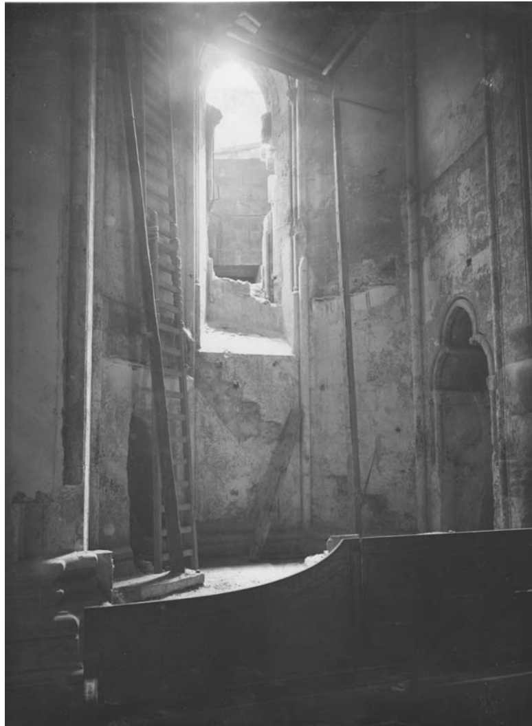
Fig. 13 Cattedrale di Santa Maria di Castello (Cagliari). Restauri della cappella del braccio sud del transetto (Foto Archivio SBAP-SAECAOR, n° 2556).
