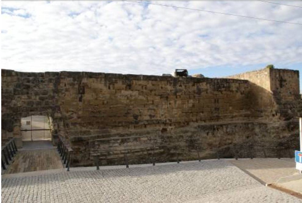
Muralla nord del Castell Formós de Balaguer. Carreu de pedra a llarg i través regular.
