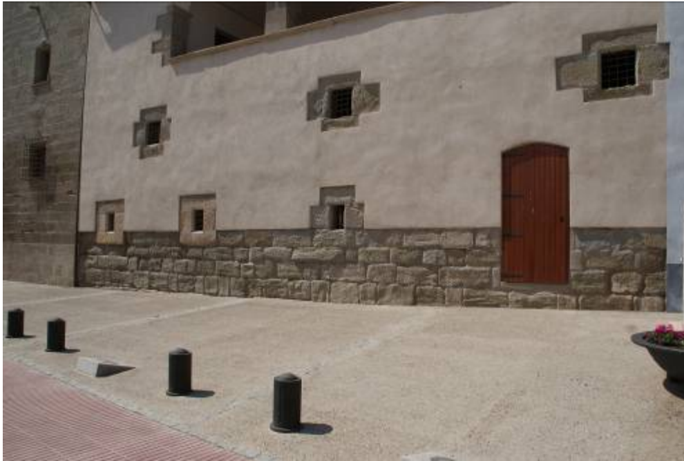
Castell de Barbens. Carreu de pedra a llarg i través irregular.
